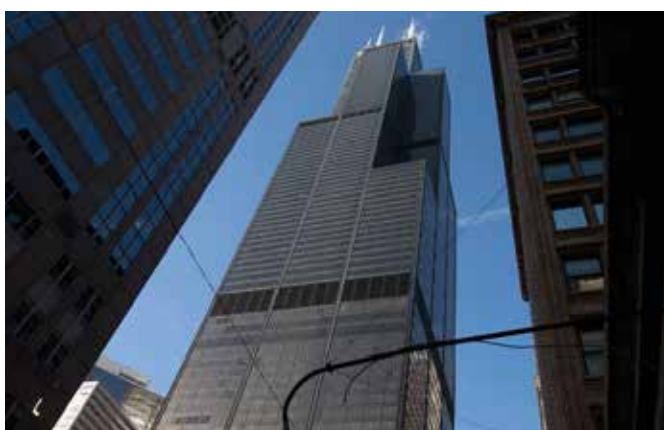
Willis Tower - USA - Clima Canal
